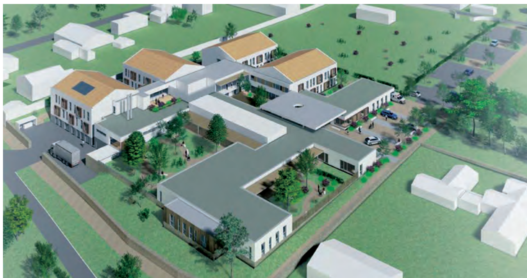
Vue aérienne sud
