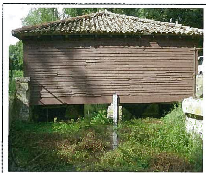
Relevé du niveau d'eau par lecture directe sur l'échelle.
