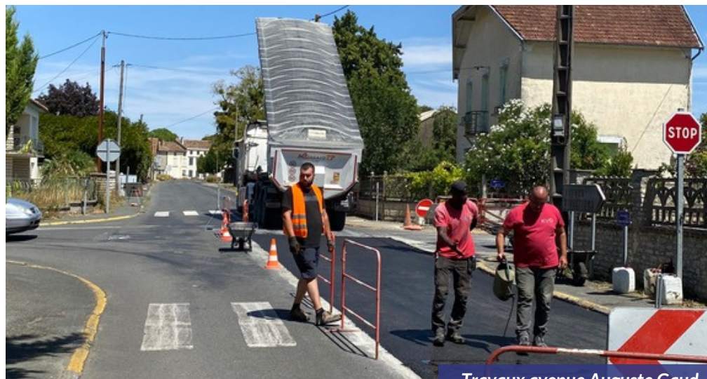
Travaux avenue Auguste Gaud
