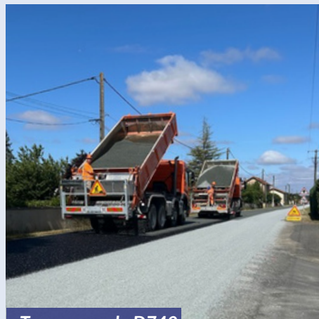
Travaux sur la D740
