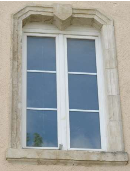
22, place Cail "petits bois" plus fins que des petits bois traditionnels > perte des proportions originelles
