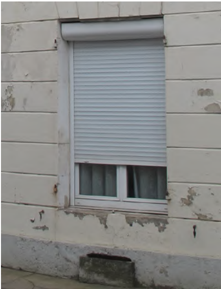
63, rue du Commerce Coffre de volets roulants extérieur et disparition des contrevents d'origine
