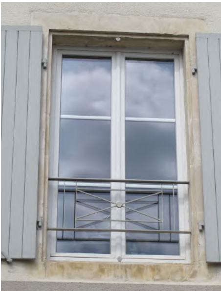
24, place Cail Petits bois à l'intérieur du double vitrage > perte des effets de reliefs de la menuiserie ancienne
