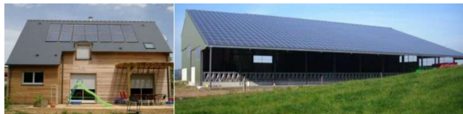
Exemples de dispositifs photovoltaïques installés sur la toiture d'une maison individuelle (intégration dans la toiture en ardoise) et d'un hangar agricole.
