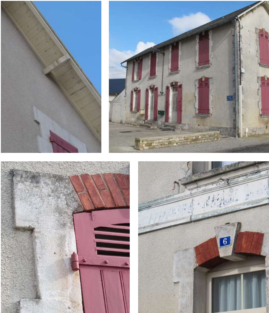
Alternance de briques et de pierre calcaire
