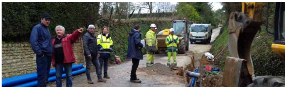
Réfection des canalisations d'eau à Tillou
