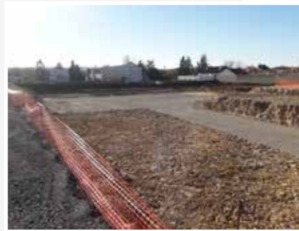
Chantier du nouvel EHPAD
