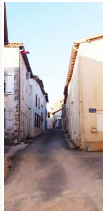
Rue de l'Huilerie après effacement des réseaux
